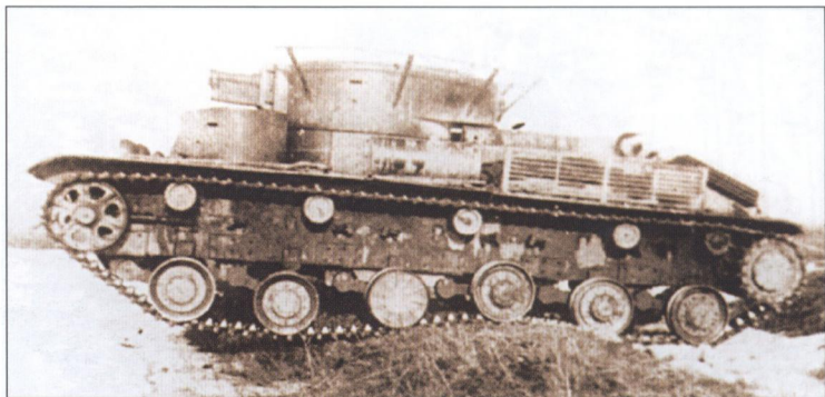
Испытания опытной торсионной подвески на среднем танке Т-28
